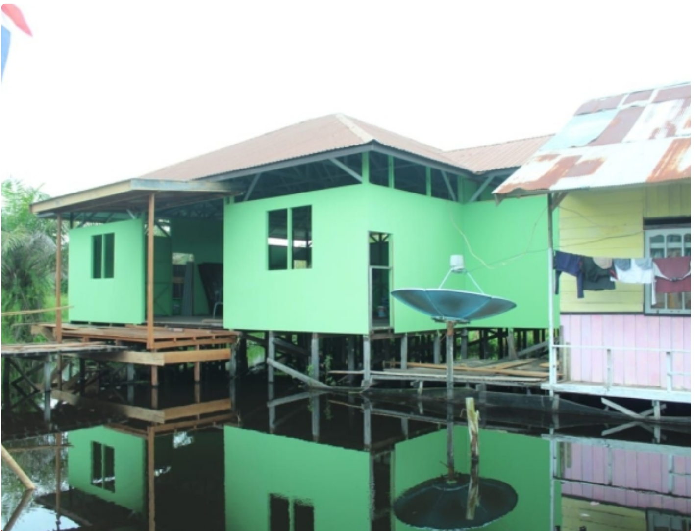
Program TMMD 115, Rehap Balai Pertemuan sudah mencapai 75 Persen
