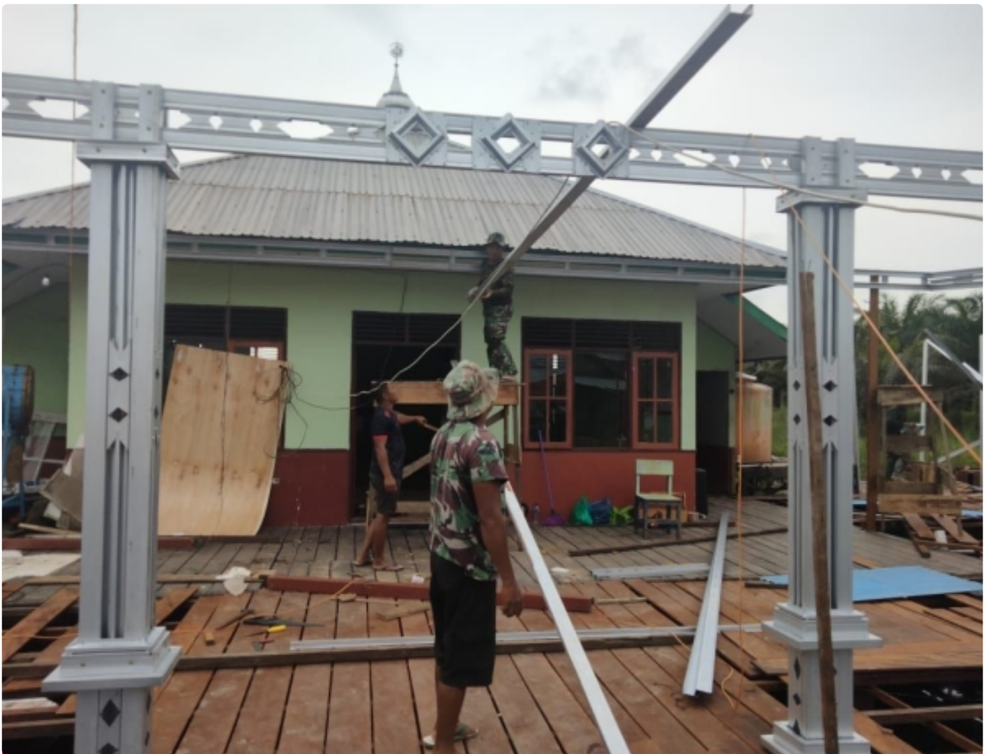
Pengerjaan Lantai dan Atap Tempat Ibadah Sebagai Sasaran Fisik TMMD
