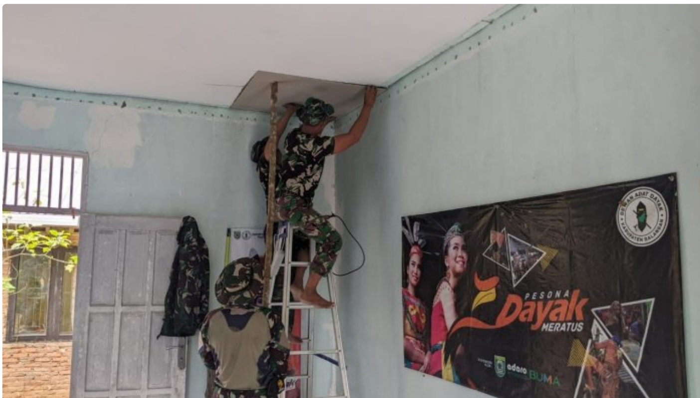
Kodim 1001/HSU-Balangan Rehap Kantor DAD Kabupaten Balangan
