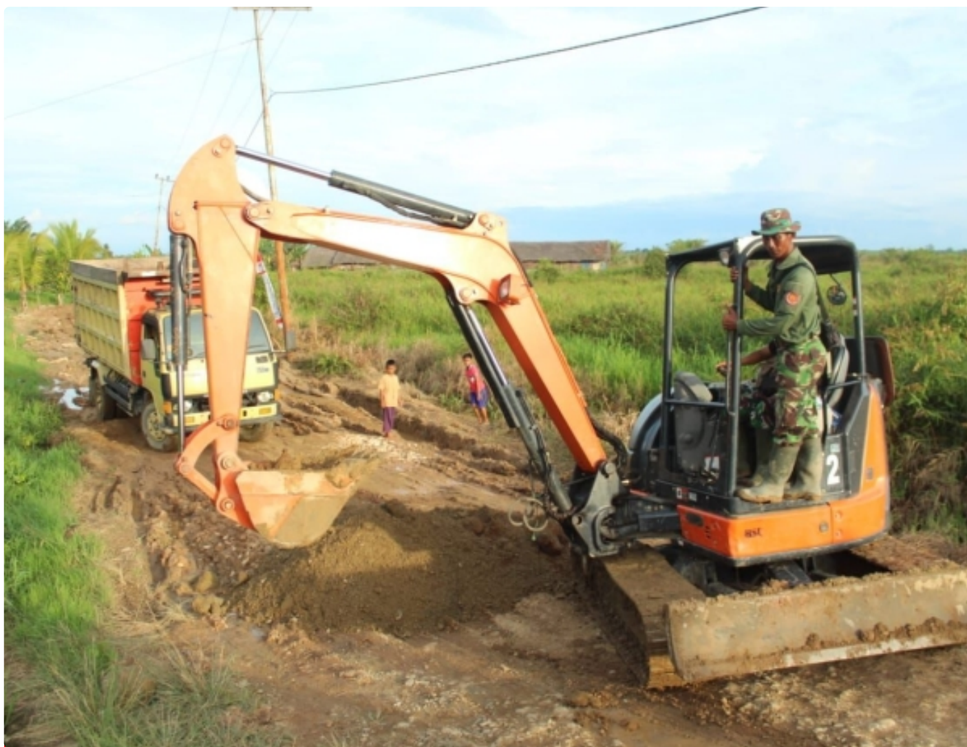
Satgas TMMD ke-115 Kodim 1001/Hsu-Blg Kerahkan Excavator
